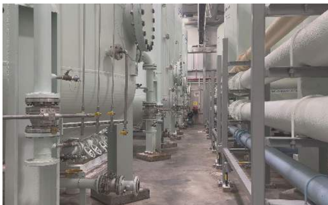
2026 Dentro de la planta: los grandes tanques de carbón por los que pasa el agua, y los tubos que los alimentan. Outdoor Promise, Sept 2026
