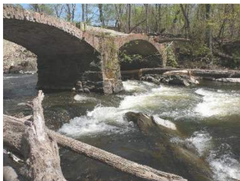
El Twin Arched Bridge sobre el Quassaick Creek — el cruce más antiguo que existe sobre el arroyo. Photo by Peter Smith
